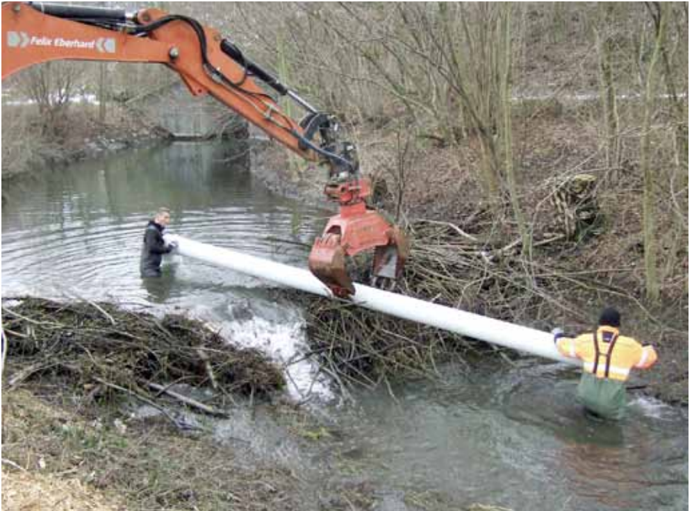
Urs Wegmann (links) beim Einbau eines Entlastungsrohres in einen Biberdamm.
